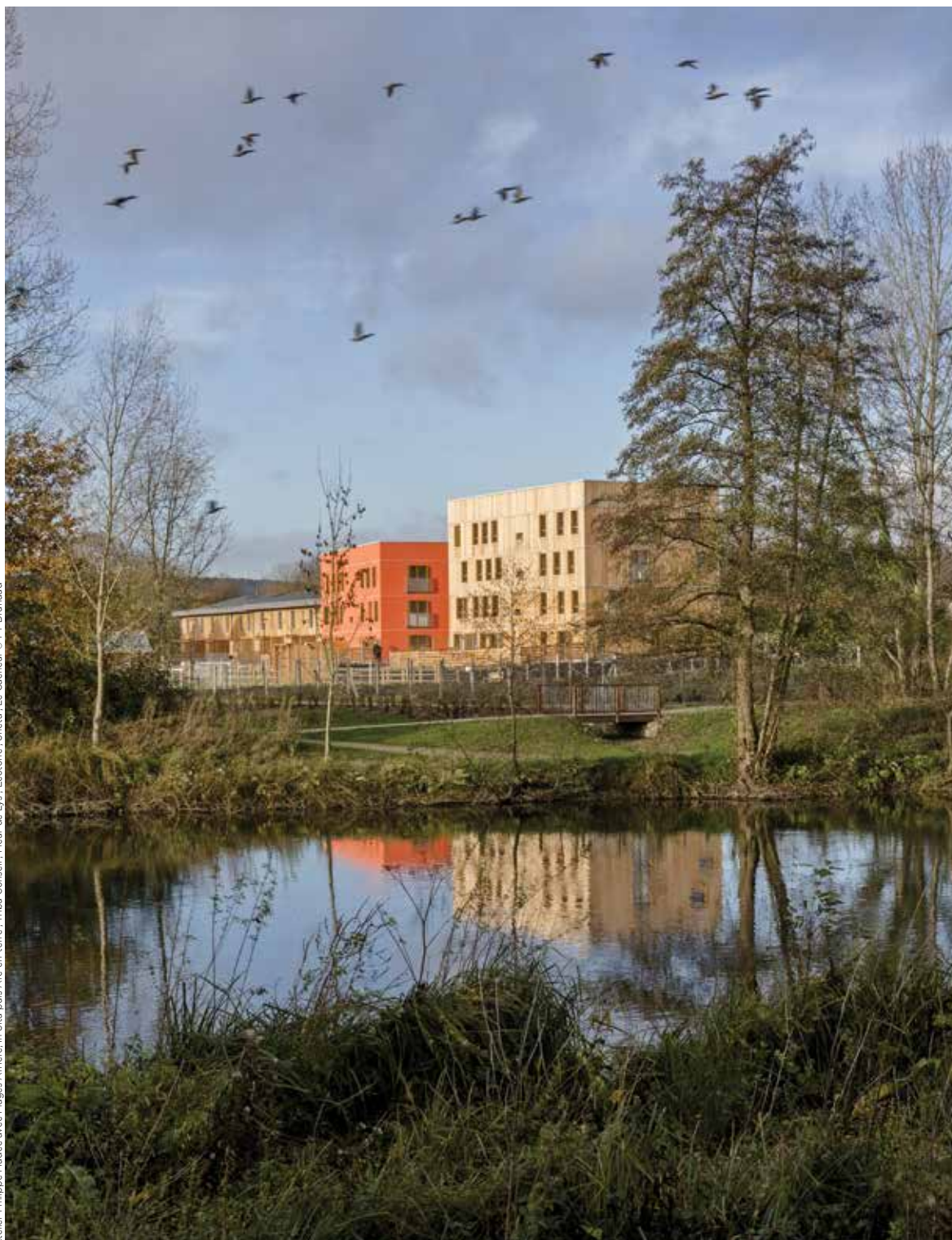
Atelier Philippe Madec avec Plages Arrière, In Situ puis Arc-en-terre, Tribu Conseil, Fleur de Lys, Ecclone, Sneto, Le Cacheur © PY Brunaud
