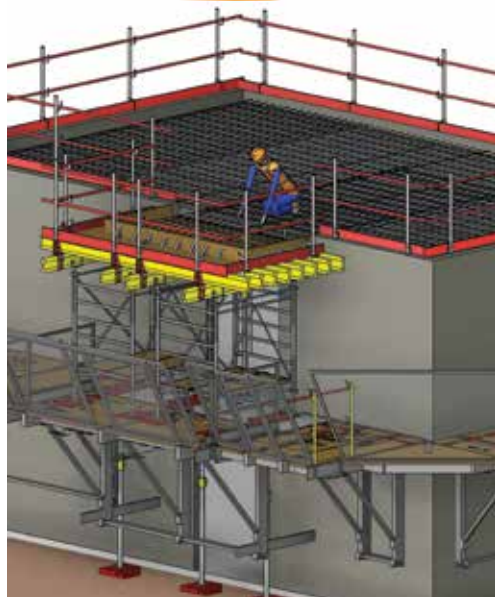
Fig. 12 • Coffrage et ferrailage du balcon (avec garde-corps intégrés).
