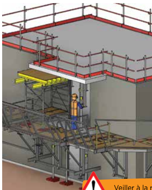
Fig. 15 • Décoffrage et pose des étais de séchage à l'avancement (sous-éaiement).
