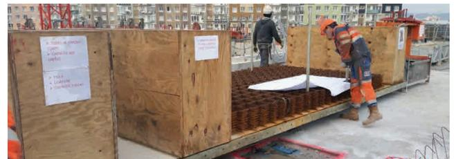
Plan de manutention au poste banche ; principe : 1 matériel = 1 contenant identifié
