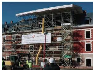
Exemple de solution pour faciliter le séquençage du chantier en toute sécurité : l'échafaudage mobile.
