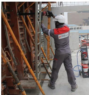
Le serrage de planche 4G. Supprimer le risque de blessure, de maladie professionnelle, de TMS au cours des phases de serrage-desserrage des écrous de planche.
