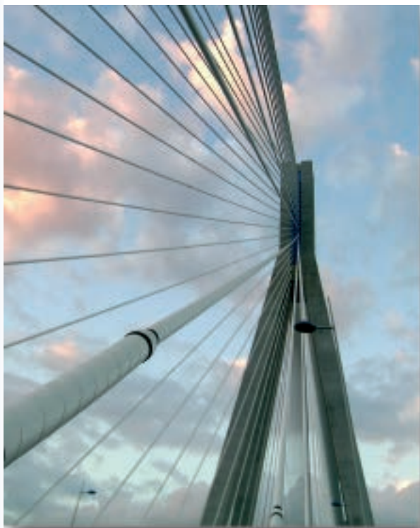
Le pont de Rion Antirion
