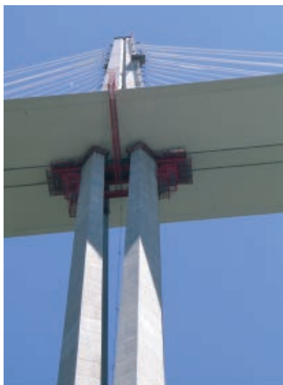
Viaduc de Millau
