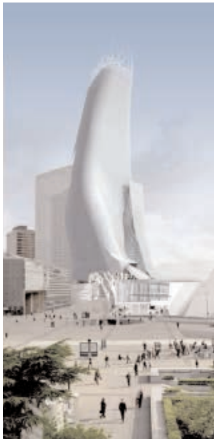
Projet phare Unibail - Architecte Tom Mayne
