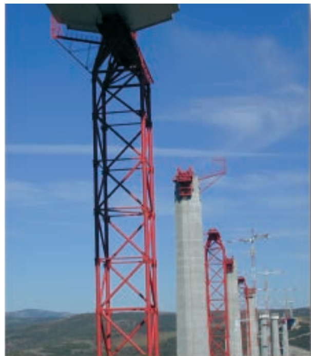
Viaduc de Millau
