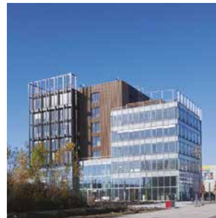
Niwa (siège social de GA Smart Building), Toulouse
