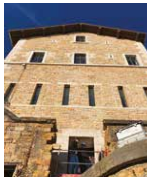
Chantier de Fort Laurent, Lyon.
