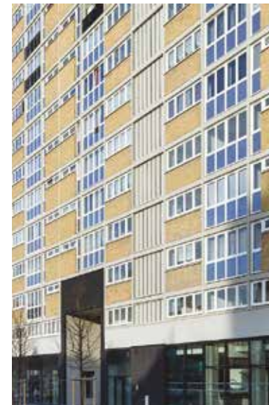
Rénovation des Tuileries, Roubaix
