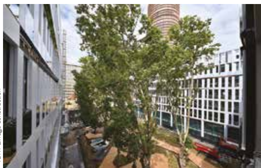
Visite du chantier de la Cité administrative d'État, Lyon
