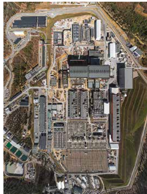
Chantier d'Iter, Cadarache
